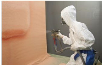
アキレスエアロンFR-FO 吹き付け施工イメージ
